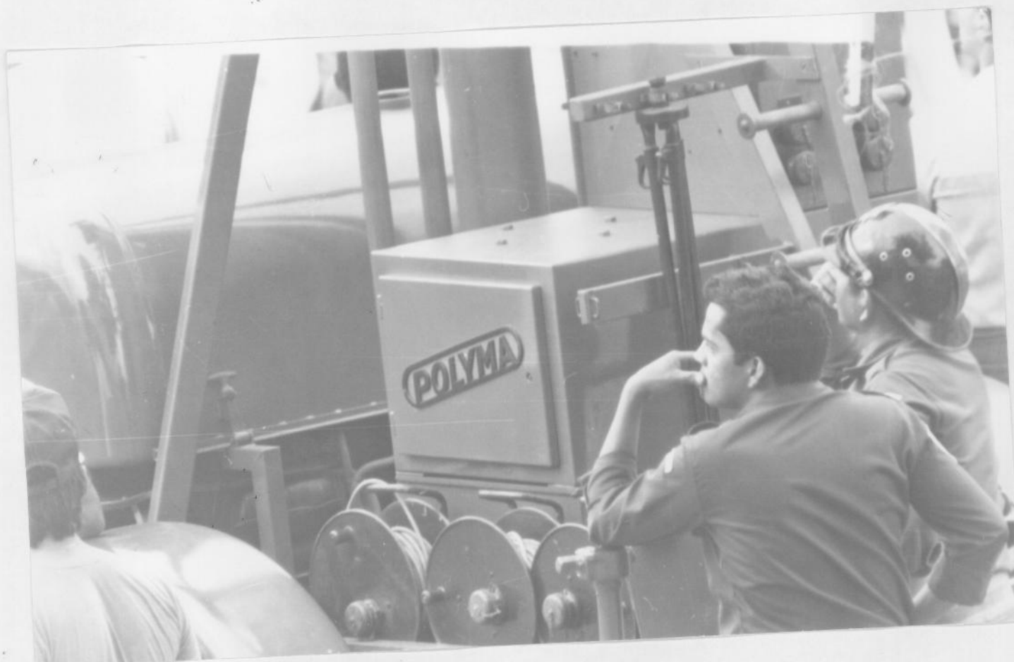
GRUPO GERADOR DO CORPO DE BOMBEIRO PRÇA DO CONGRESSO
