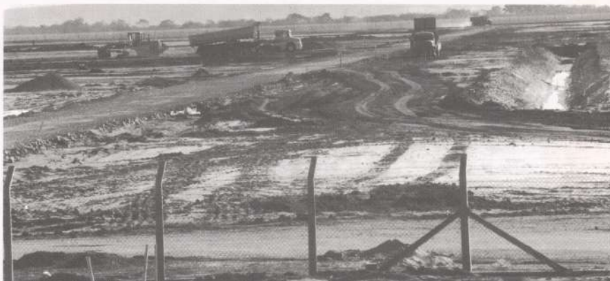
Início das obras do complexo automotivo da FORD, em Guaíba
